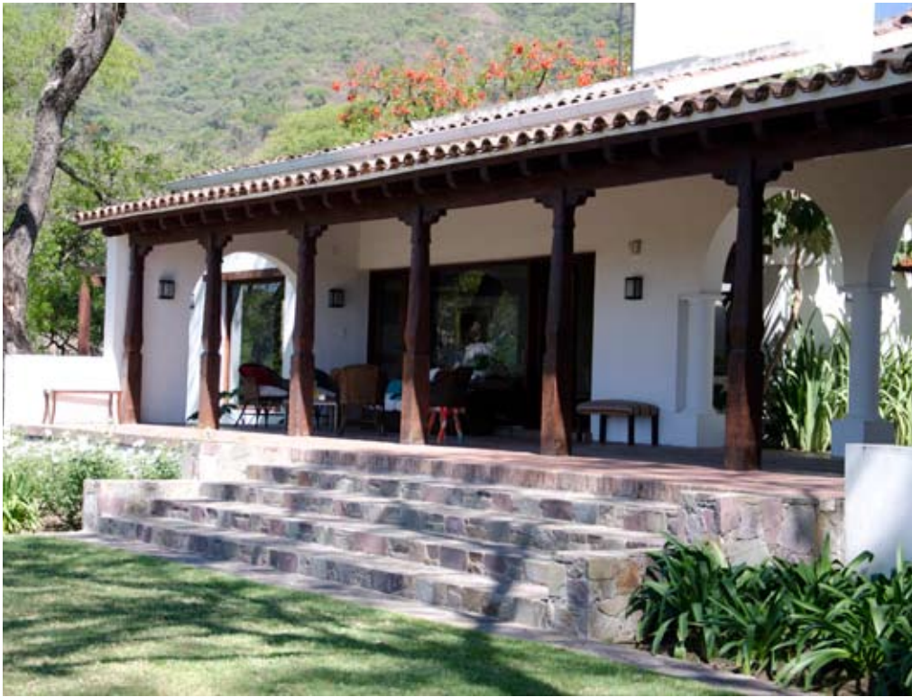
La galería con sus columnas talladas, típico del estilo colonial. Atrás se puede observar un ceibo salteño en flor. A la derecha, otro de los patios.
